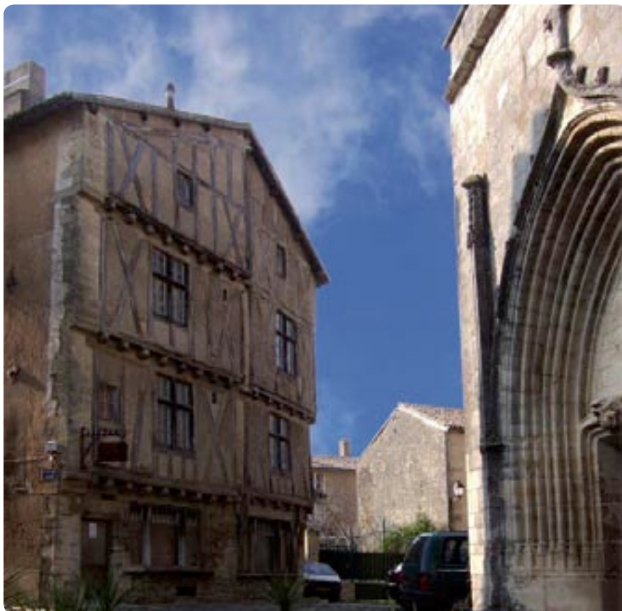
L'église de style roman poitevin possède un porche qui fait face à une maison du XV e siècle à pans de bois et en encorbellement.
